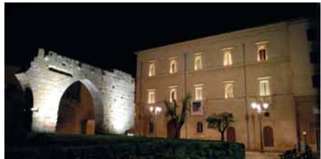
Palazzo Nervegna, Brindisi (0,8 kW di potenza impegnata)
