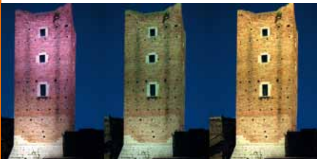
Torre del Castello di Romeo, Montecchio Maggiore (1,5 kW di potenza impegnata)
