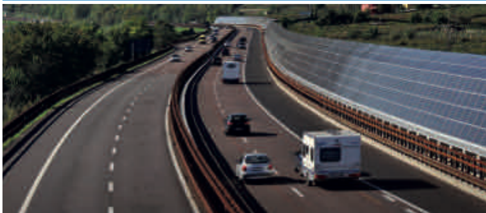
Pannello fonoassorbente fotovoltaico, Comune d'Isera (TN)
