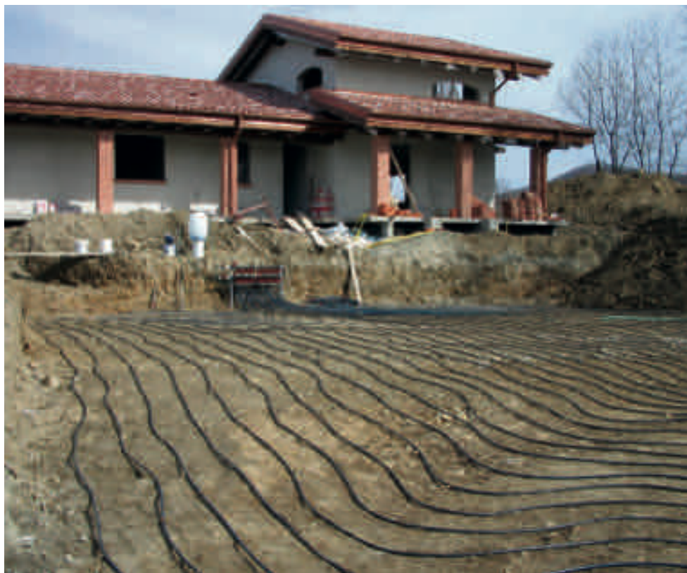
Impianto geotermico orizzontale, Comune di Settimo Rottaro (TO)
