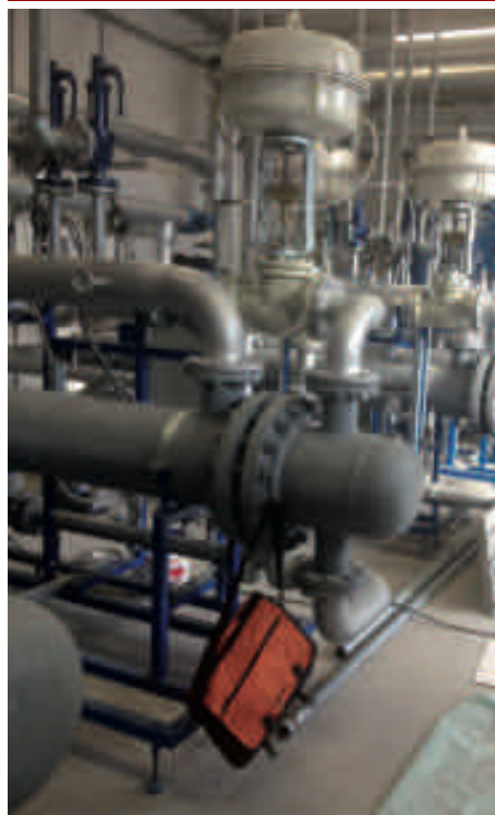
Centrale geotermica, Comune di Montieri (GR)
