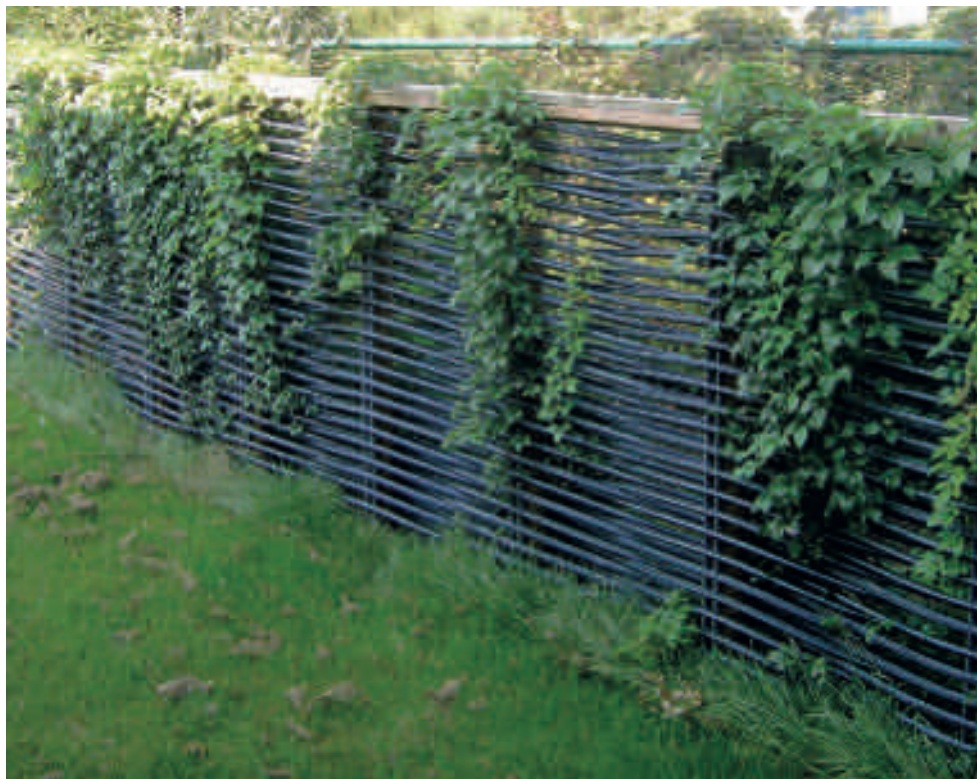
Impianto geotermico a palizzata
