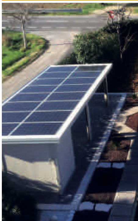
Impianto fotovoltaico su pensilina posto macchina in abitazione privata, Comune di Ancona (AN)
