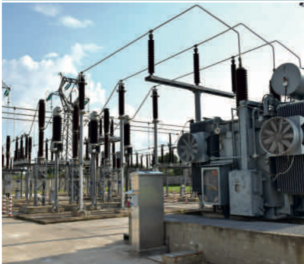
Cabina di trasformazione smart, Comune di Grumo Appula (BA)
