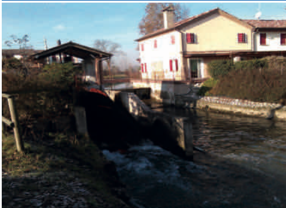
Impianto mini idroelettrico nel Comune di Zero Branco
