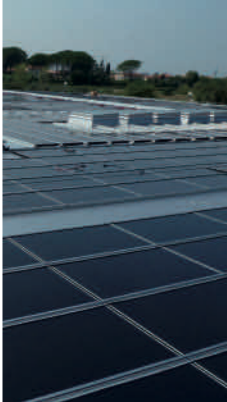
Pannello solare termico nel Comune di Cascina (PI)
