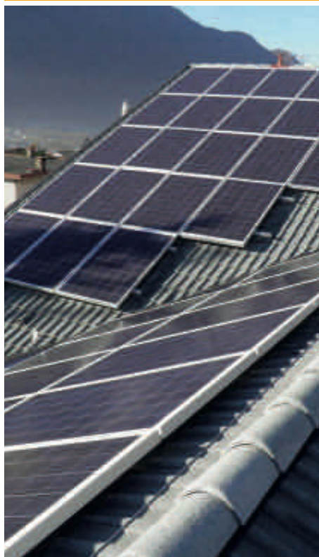
Impianto fotovoltaico su asilo, Comune di Berbenno di Valtellina (SO)
