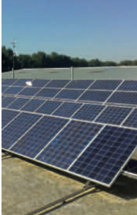
Impianto solare, Tenuta di Lago d'Anice, Comune di Castellaneta di Marina (TA)
