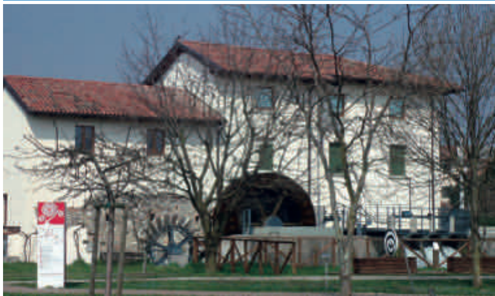
Impianto idroelettrico su ex mulino, Comune di Tavagnacco (UD)
