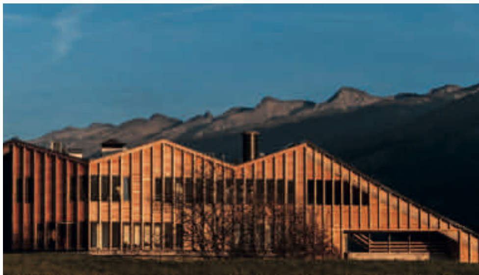
Impianto di teleriscaldamento, Comune di Cavalese (TN)
