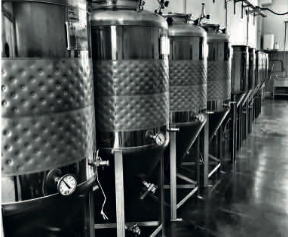
Maturatori birrifico Lesster, Comune di Grezzana (VR)
