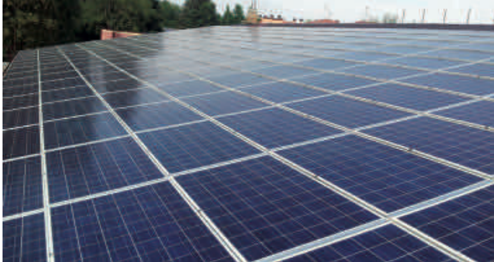
Impianto fotovoltaico su copertura scuola materna, Comune di Renate (MB)
