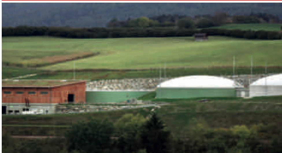
Impianto biogas Comune di San Lorenzo (BZ)
