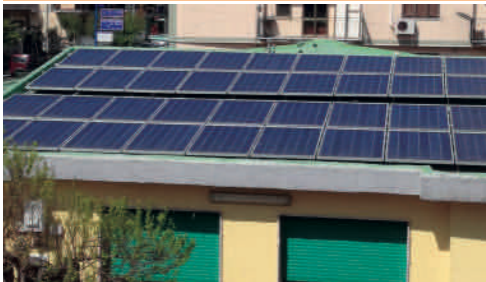
Impianto fotovoltaico scuola, Comune di Castellammare di Stabia (NA)
