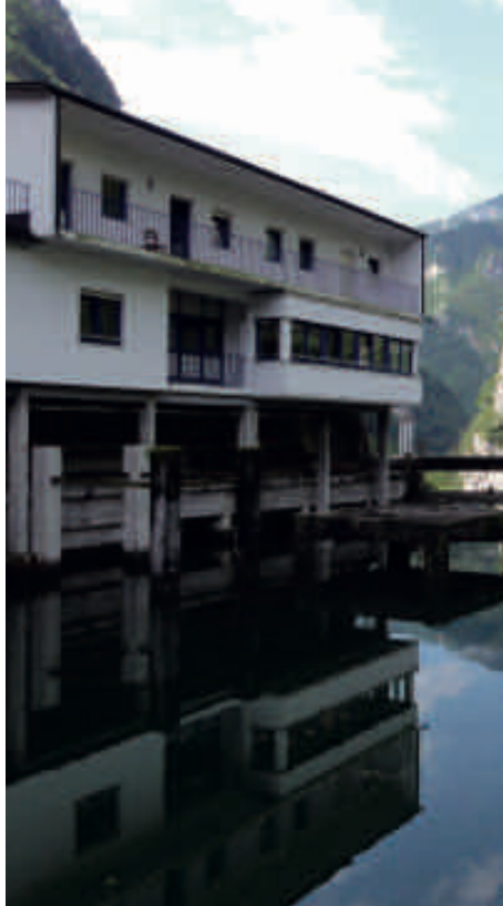
Impianto idroelettrico, Comune di Primiero San Martino di Castrozza (TN)
