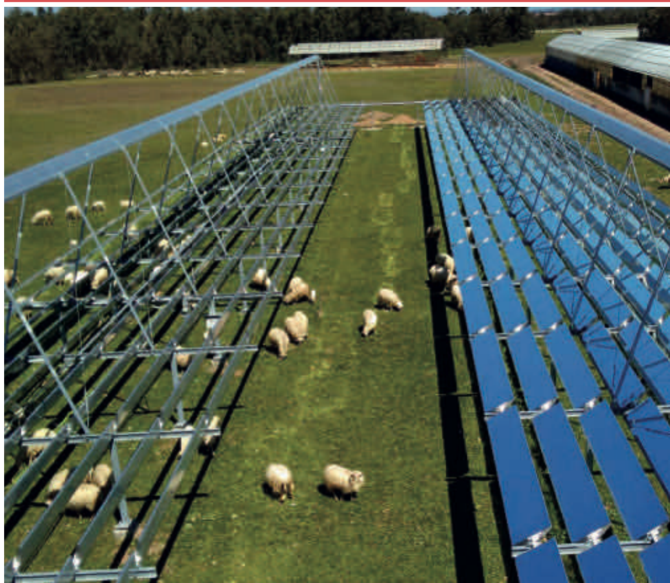
Impianto solare termodinamico, Formaggi Fanari Nuova Sarda, Comune di San Nicolò D'Arciano (OR)
