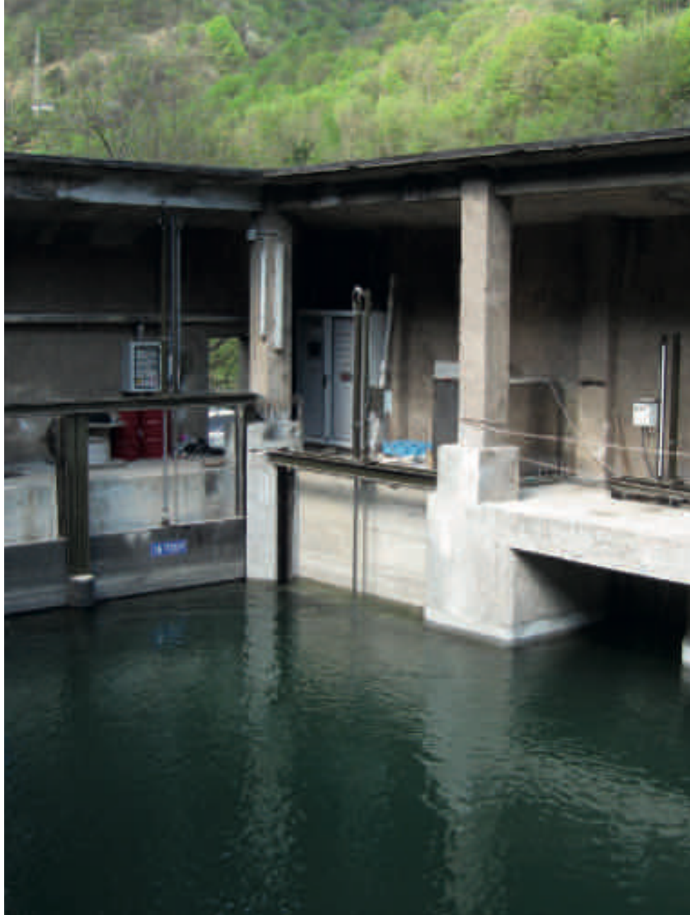
Impianto idroelettrico, Comune di Brunico (BZ)
