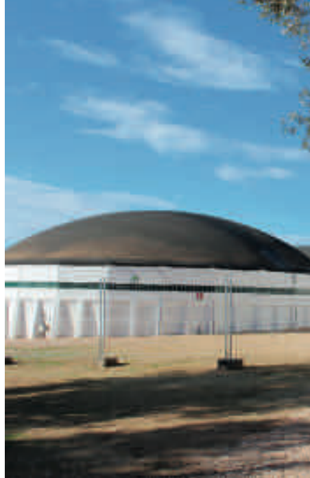
Impianto a Biogas, InMasseria, Comune di Grottaglie (TA)
