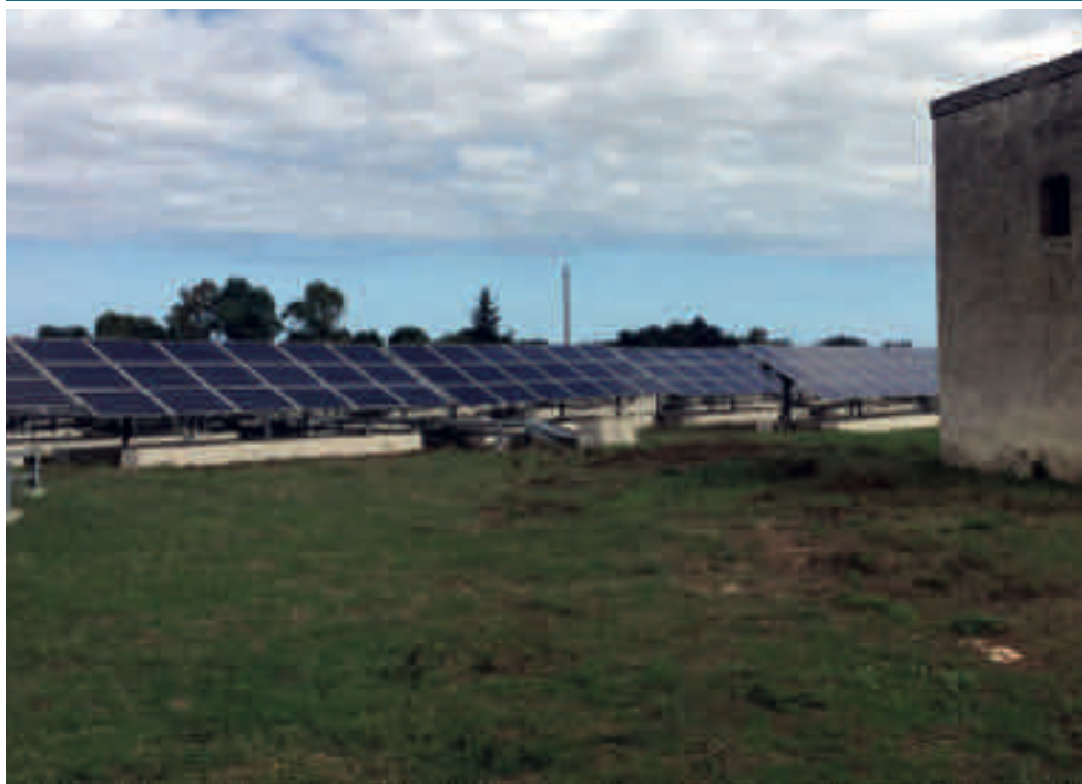
Impianto solare fotovoltaico su ex discarica, Cooperativa We For Green, Comune di Lecce
