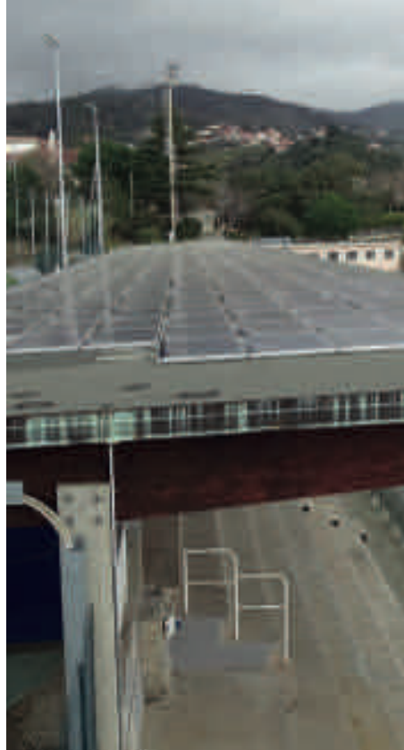
Gradinate, Comune di Celle Ligure (SV)
