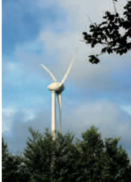
Parco eolico Valbormida, Comune di Cairo Montenotte (SV)
