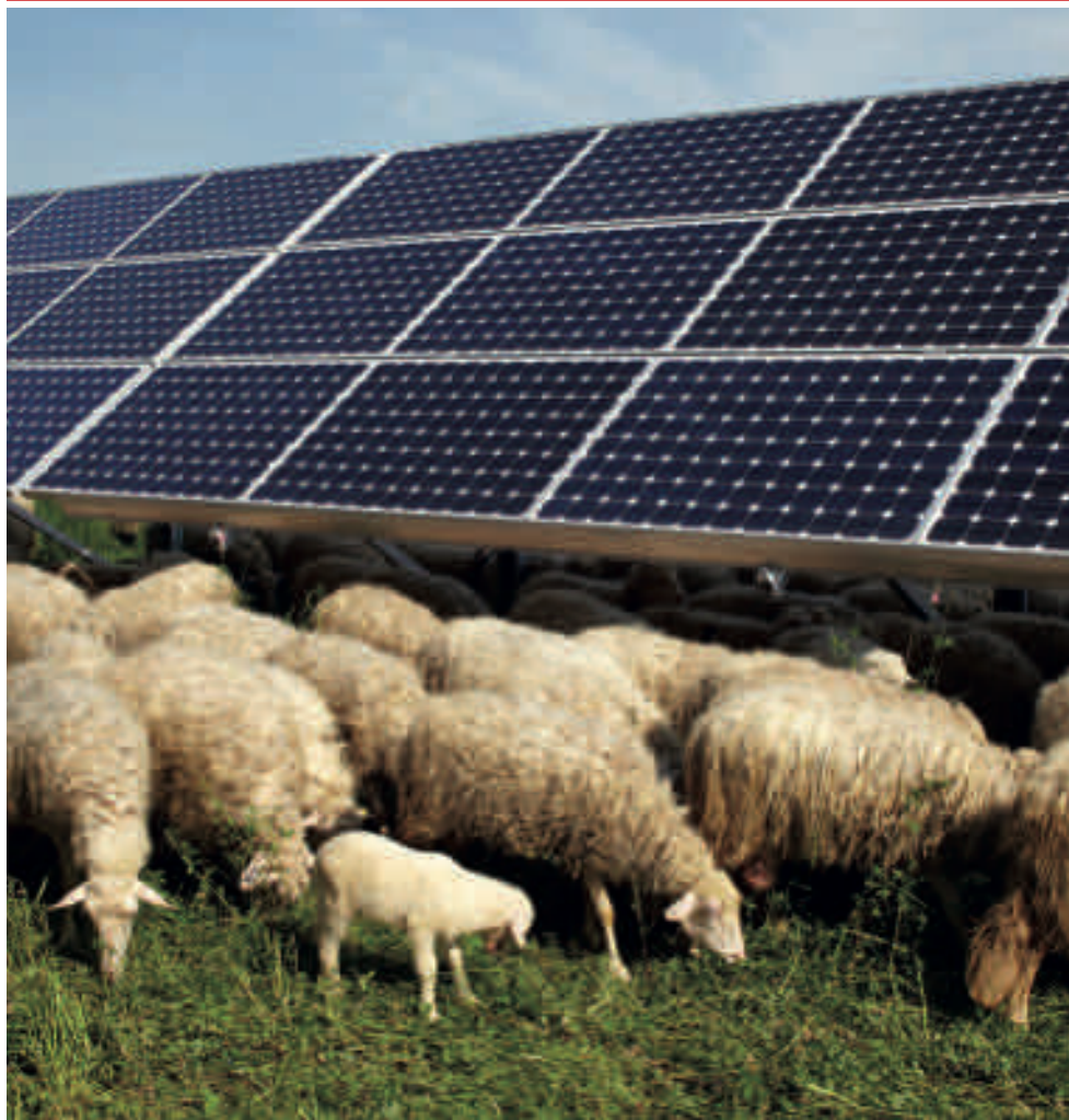
Impianto solare fotovoltaico, Caseificio Buon Pastore, Comune di Sant'Alberto di Ravenna
