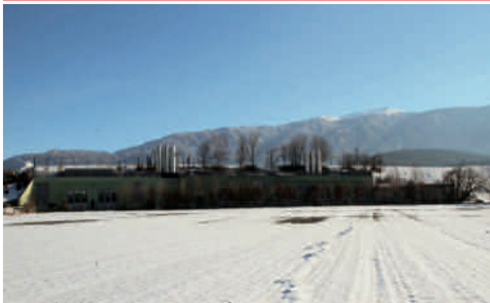
Centrale di teleriscaldamento, Comune di Brunico (BZ)
