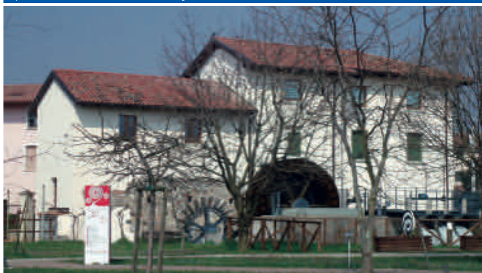
Impianto idroelettrico su ex mulino, Comune di Tavagnacco (UD)
