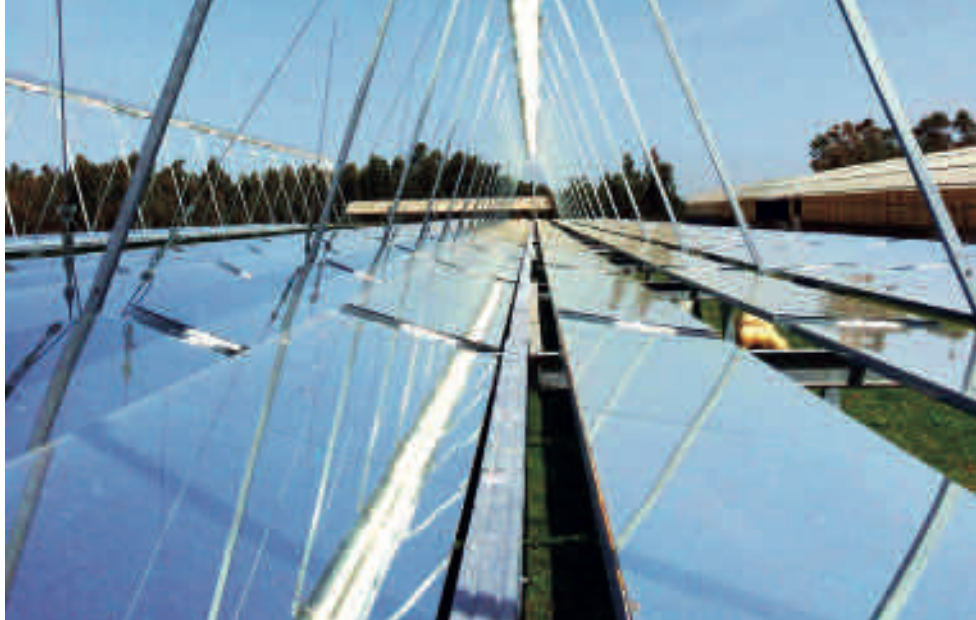
Impianto solare termodinamico, Formaggi Fanari Nuova Sarda, Comune di San Nicolò D'Arciano (OR)
