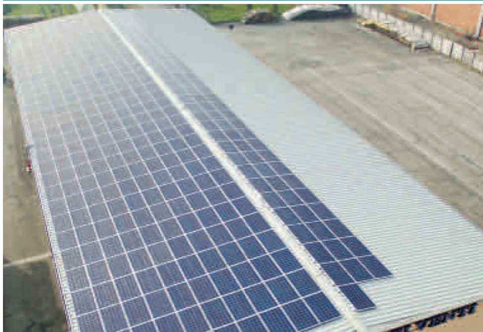
Copertura di capannone con pannelli fotovoltaici, cooperativa EPOSITIVA
