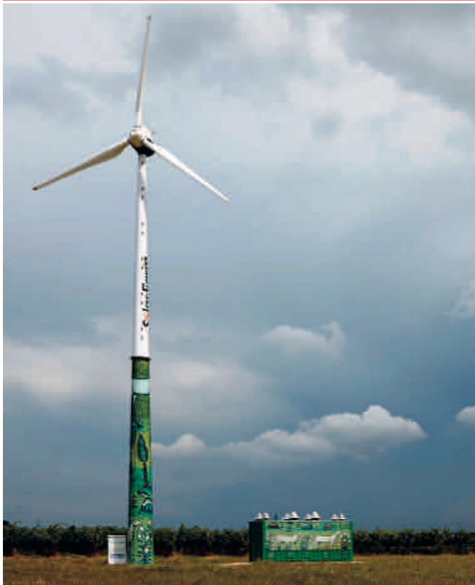
Pala eolica, Caseificio Buon Pastore, Comune di Sant'Alberto di Ravenna
