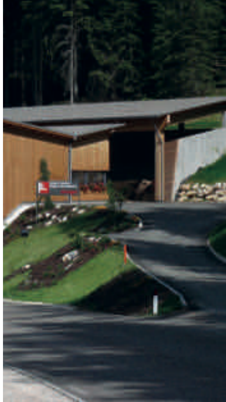
Impianto di teleriscaldamento, Comune di Obertein (BZ)
