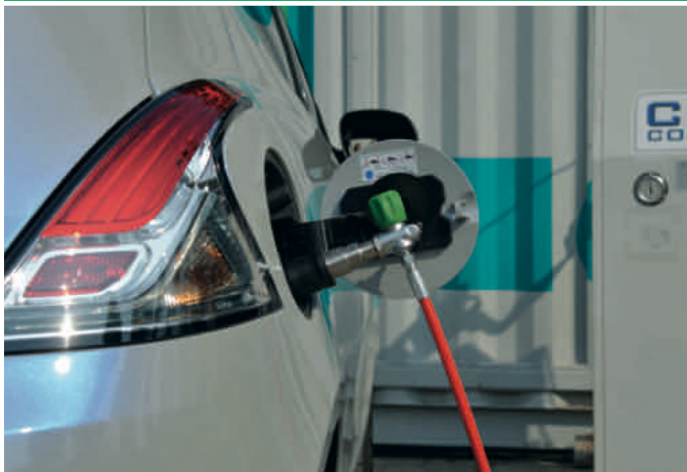
Particolare di alimentazione con biometano
