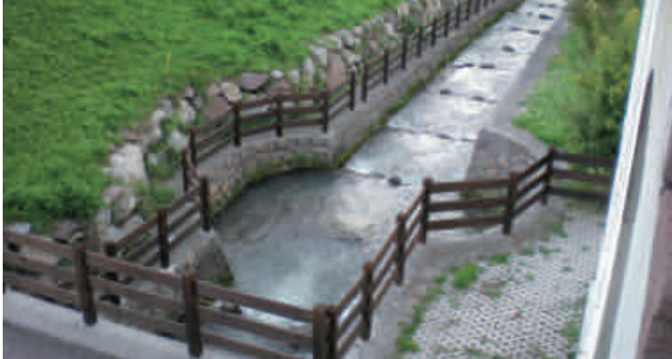
Impianto di risalita dei pesci della centrale idroelettrica "Claudio Castellani" nella Bassa Valle Isarco
