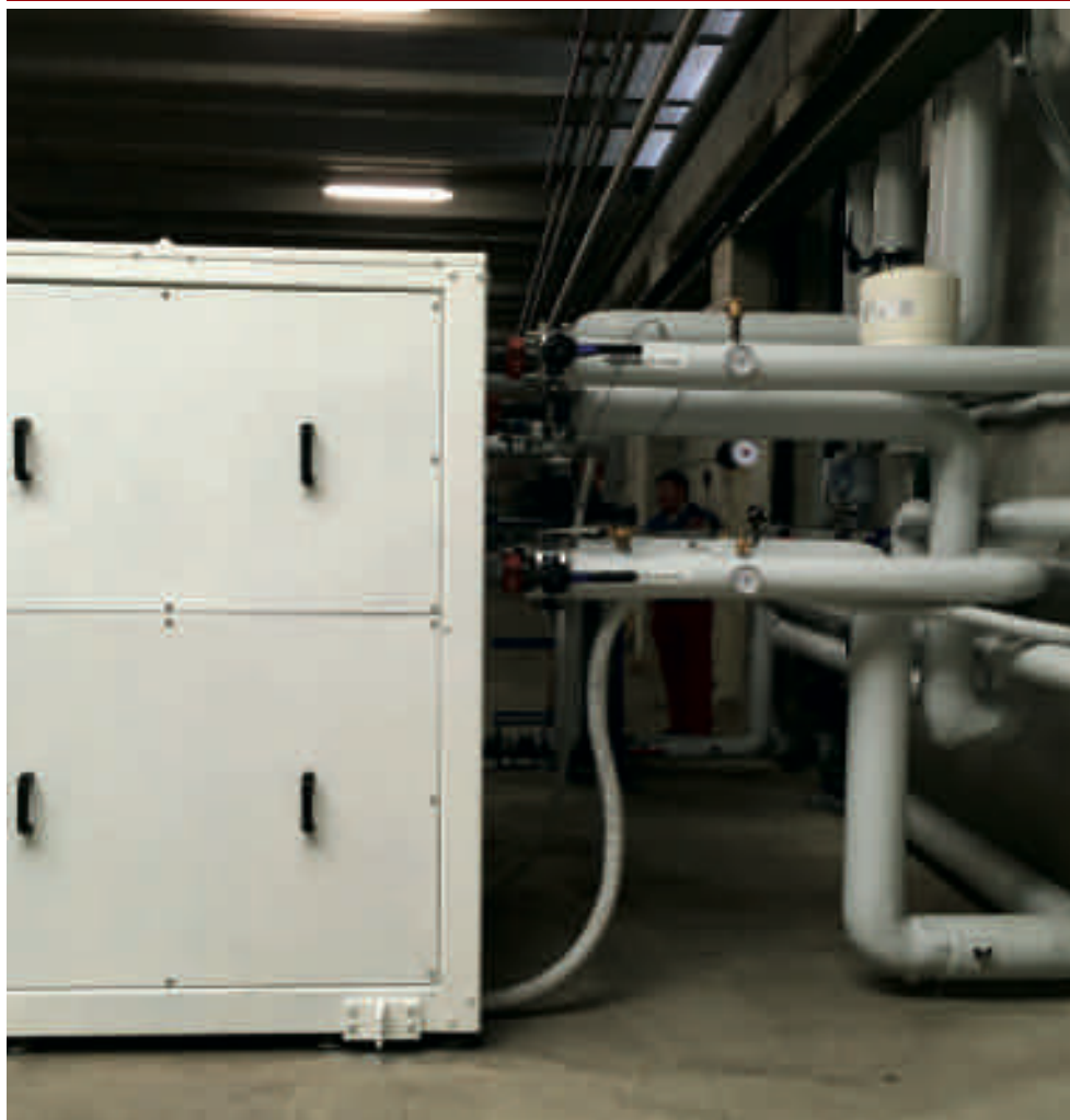
Pompa di calore, Comune di Alpignano (TO)
