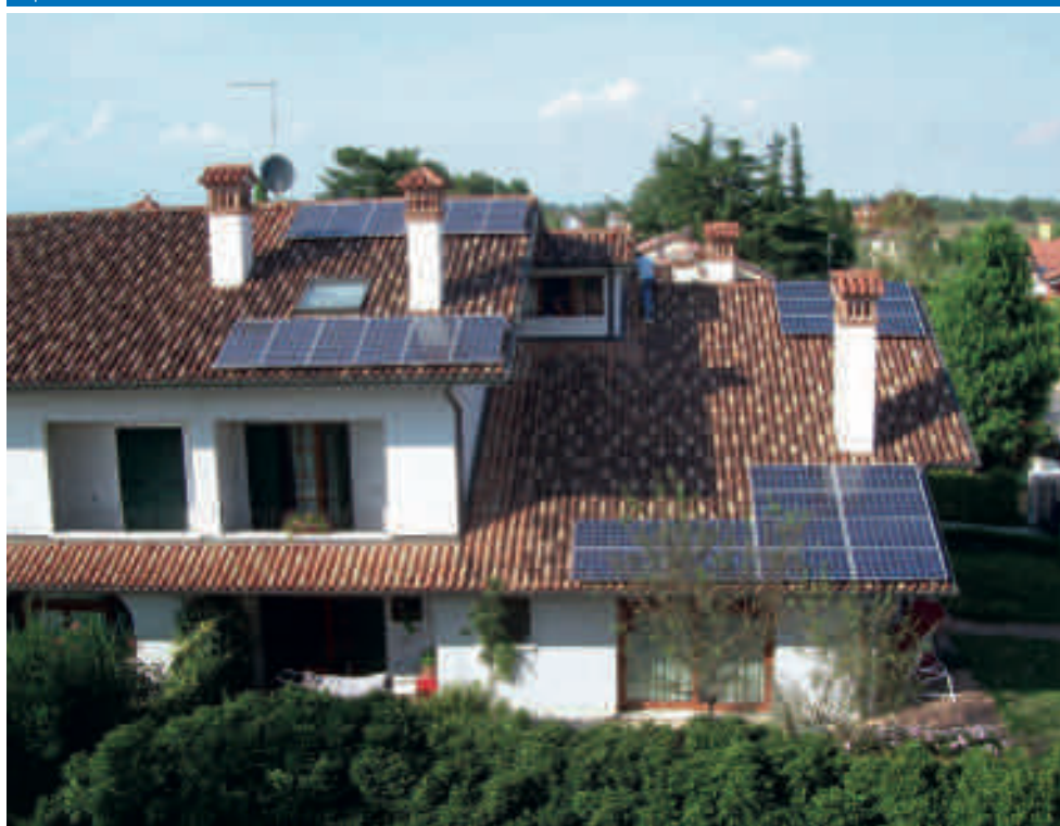
Impianti fotovoltaici su tetto
