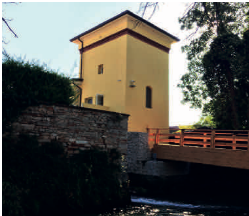
Particolare dell'impianto mini idroelettrico della cooperativa We ForGreen, Comune di Montorio (VR)
